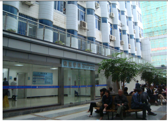
照片 2 医学影像楼南侧
