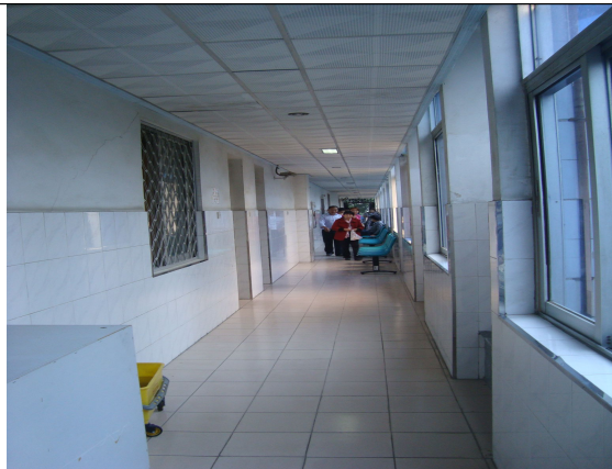
照片 9 拟建值班室、接诊室北侧走道
