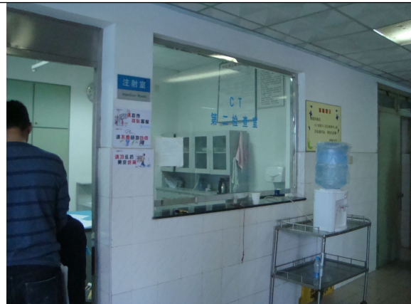
照片 10 拟建甲癌治疗病房正上方 CT 第二检查室
